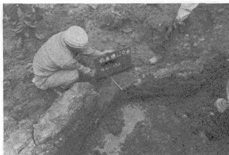
写真-3 鉛直膜面閉合状況
