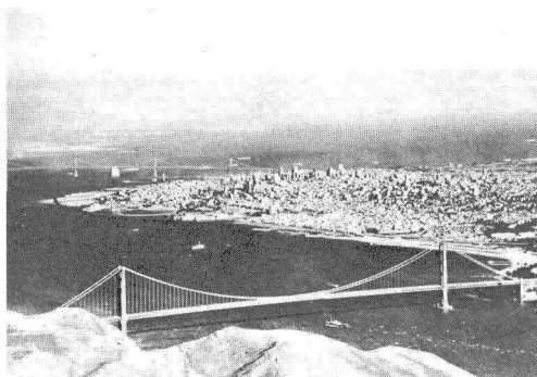
Fig 9. ゴールデンゲート橋*
