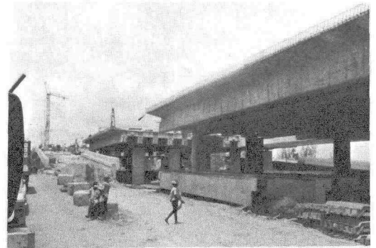
写真-1 交通緩和のため首都 Lagos に建設中の高速道路
