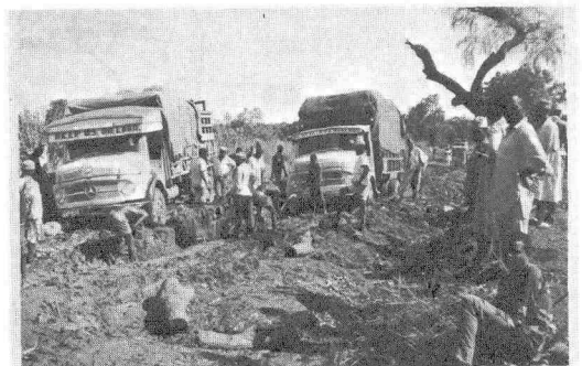
写真-2 早急な道路補修が望まれる地方道
