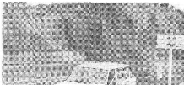
写真-6 道路脇切取崖 勾配5～6分 野芝張保護工
