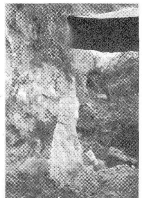
写真-11 地震による割落
