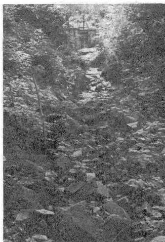
写-5 第二区間の状況
