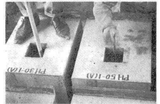
写真-1 後埋めコンクリートの打ち込み
