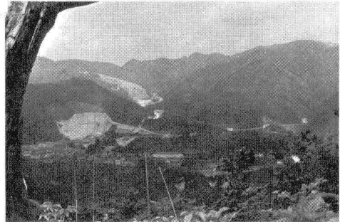
写真-1 栗子トンネル全景(板谷地区)
