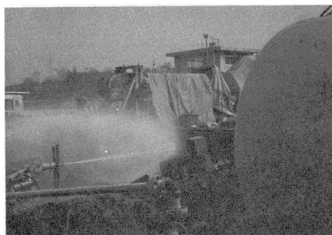
写真-1 ノズル固定実験
