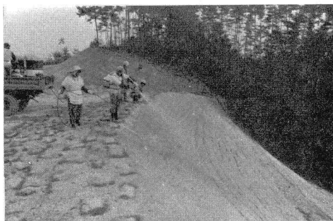
(写真-2) 施工状況
