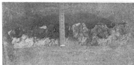
写真-2, 中性化試験。左: フェノールフタレン、右: フェノールレッド
