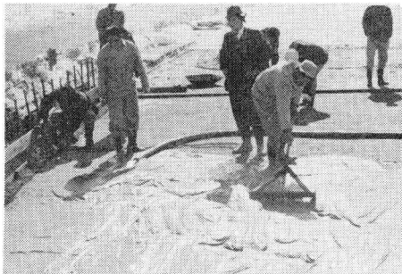
写真-1 泡コン層の打込み状況(昭. 41. 1.)
