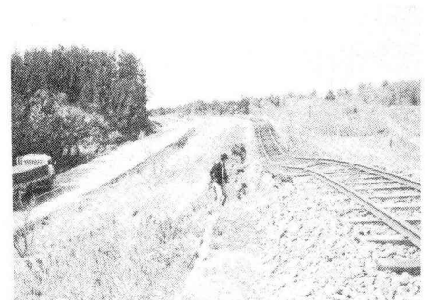
写真-6 大湊線盛土の崩壊
