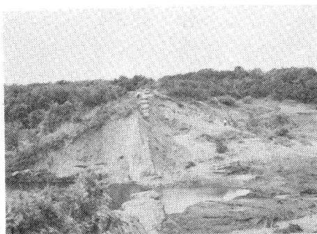
写真-8 一里小屋溜池の欠壊
