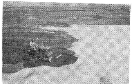
写真-2 シート上のまき出し施工状況(堺)
