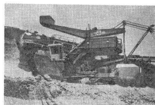
写真-1 バックホウエクスケーターによる掘削
