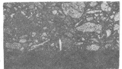
アスファルトコンフリート破断部
