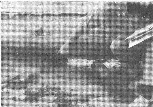
図-3b、地中への分岐配管の切断
