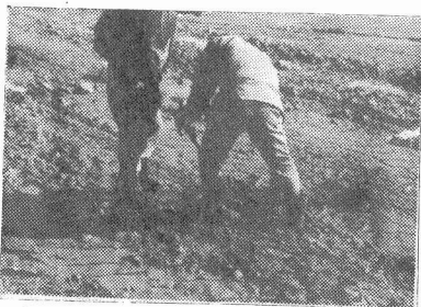
図-2 施工後ヘドロ上で作業可能
