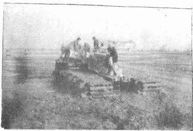
図-1 泥上車により施工中
