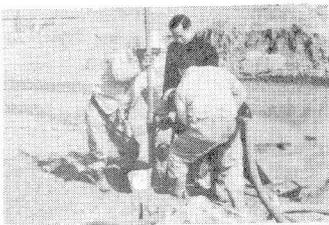
写真-7 2号ノズルを試作して射水設置を行っている様子
