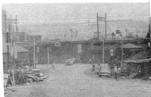
写真-1 着工前の大崎道架道橋
