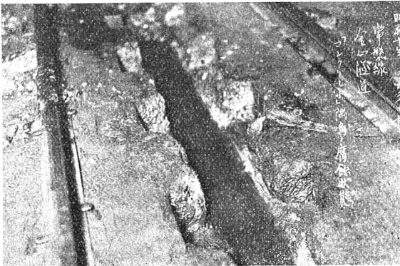
図-5. 常磐線金山隧道内コンクリート道床の隅角の腐蝕状態
