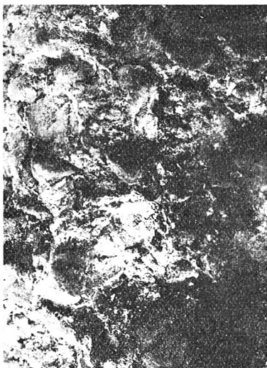
図-4. 常磐線金山隧道内コンクリート道床の状態、拱頂部よりの湧水の爲常に洗滌せられ腐蝕殆ど無き箇所
