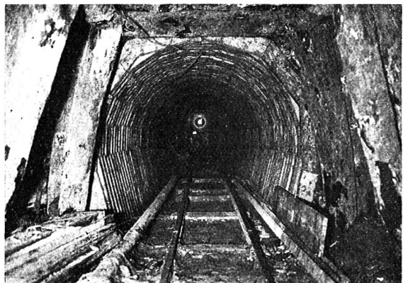
網代口 1560 m 附近地質不良個所底設導坑補強支保構
