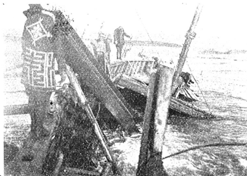
圖-36. 昭. 12. 3. 2. の洪水に依るベント基礎の被害
