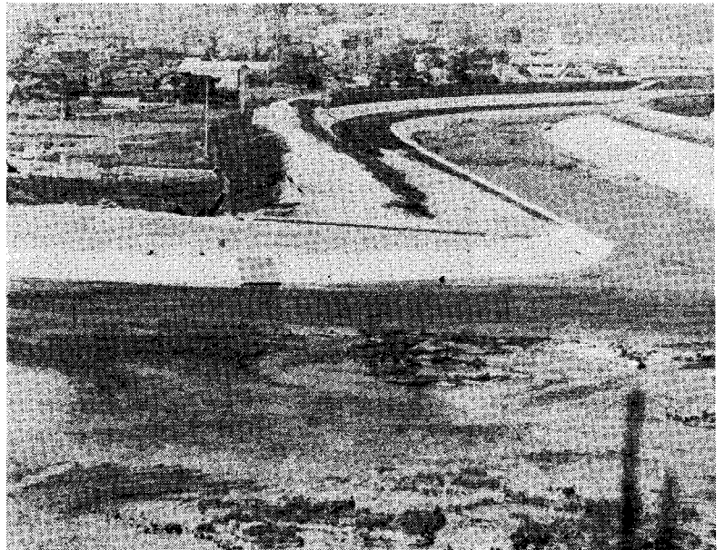
写真一4 太田川河川改修
