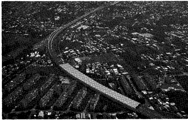
防音対策として設けられた 全長 245 m の鳥山シェルター。
