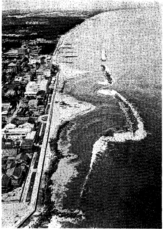
※今月の表紙※ 皆生海岸離岸堤。皆生海岸を東上空から望む。昭和46年度中央、昭和47年度予算、昭和48年度後方を施工、トンボロが発生し、砂浜の回復がもたらされた(建設省倉吉工事事務所提供)。
