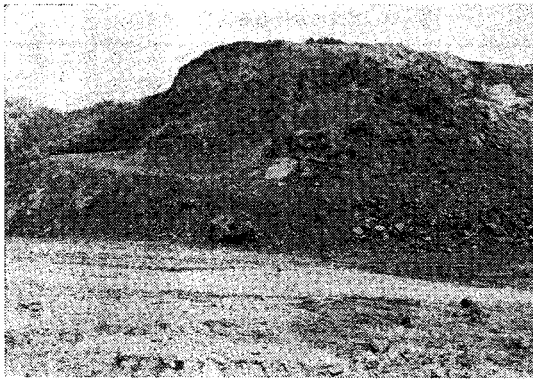
写真-3 原石山の環境保護工
