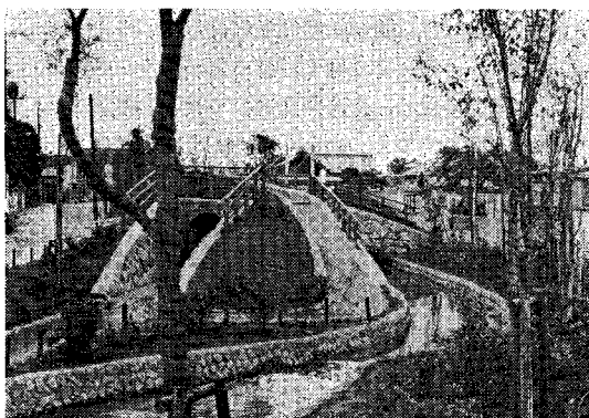
施工前(上)と施工後(下)の古川親水河川工事下流部
