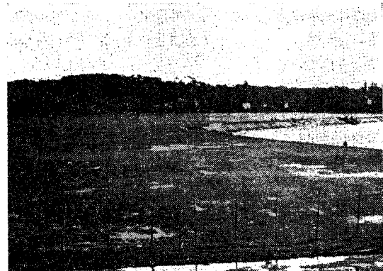
写真-4 破碎ゴミによる海岸埋立の例 3)
