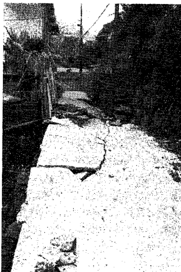
石廊崎地区・断層上の道路被災状況
