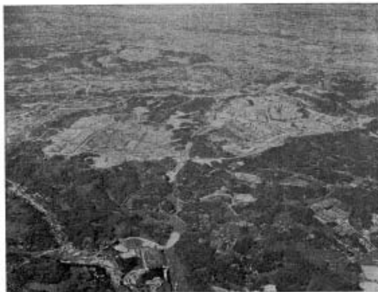
34 今月の表紙 34 南側上空からみた多摩ニュータウンの開発状況。 中央左の宅地部が第 7~10 住区である (日本住宅公団提供)。
