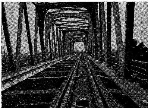
奥羽本線第1平川橋梁
