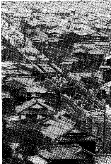
姿を表わした鳥取駅高架化工事
