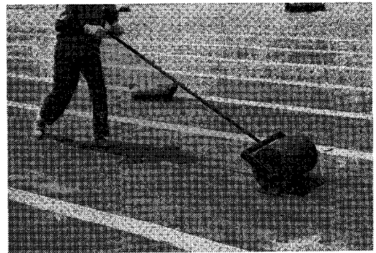
写真-6 接着部の転圧
