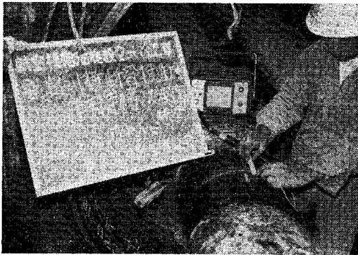
写真-11 溶接部の超音波探傷検査
