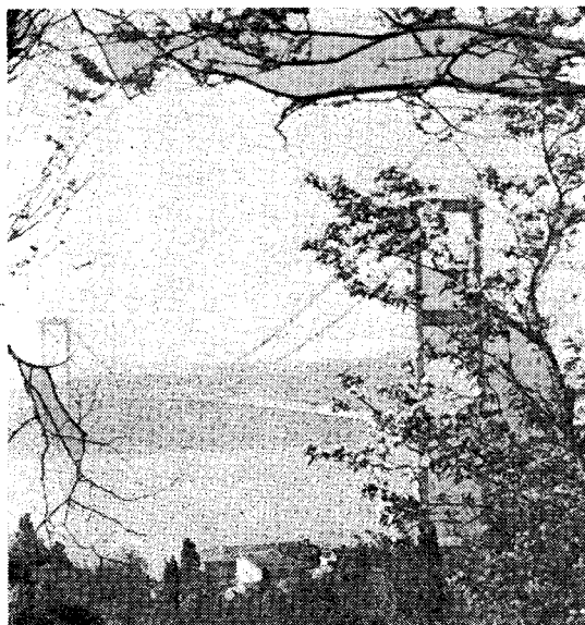
施工中のボスポラス橋
