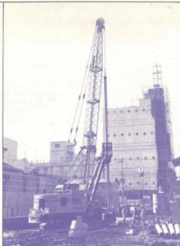
U106A 日立アースドリル ブーム長さ…17m 掘削孔径…500-1300mmφ(標準100)
