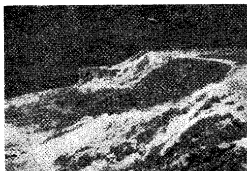
写真-3 仮締切り、越流後 10 分
