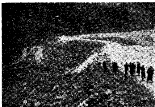
写真-2 仮締切り越流寸前
