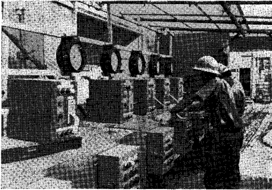
写真-3 注入記録装置
