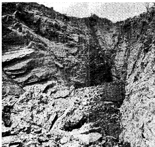
写真一1 島尻粘土層の崩落跡
