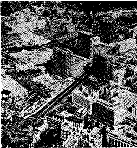
写真一 建設中のパリーカン市街地
