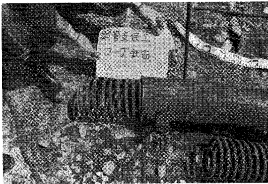
写真-4 フープ付き鋼管支保工
