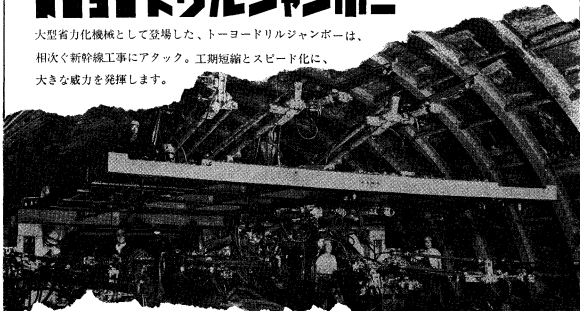
★青函トンネルで活躍中の上半9ブームジャンボ
