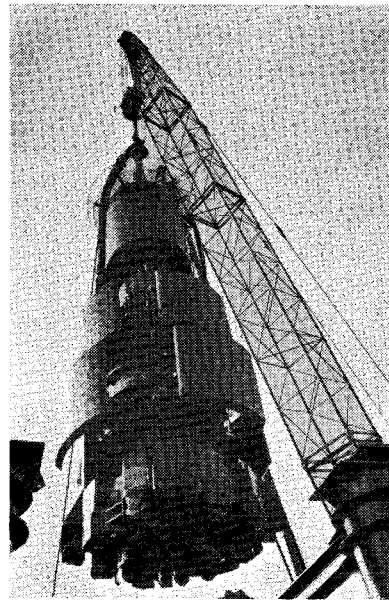
写真—5 ロータリー式掘削機
