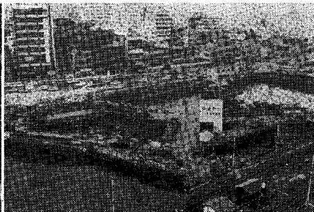
都営8号線・市ヶ谷工区の下床コンクリート打設後の足場組 都営10号線・市ヶ谷塚の工事
