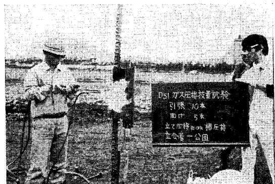
写真-2 縦継圧接
