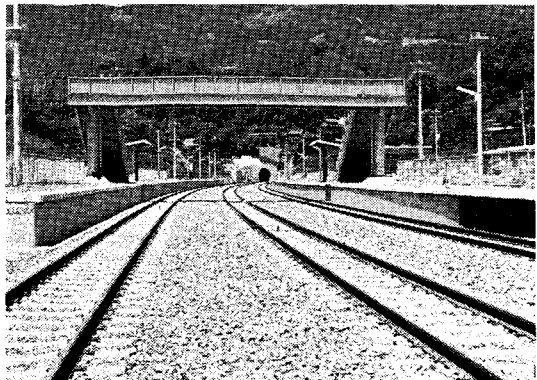
現川停車場と長崎トンネル入口
