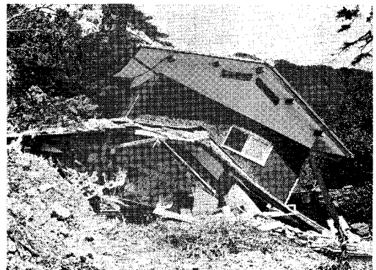
写真一13 山口県の崖崩れの被災状況
