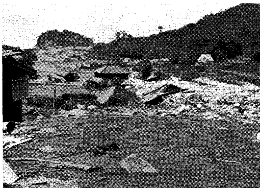
写真-7 熊本県宮田川の被災状況
