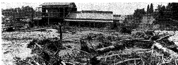
写真—10 岐阜県八ヶ洞の被災状況
