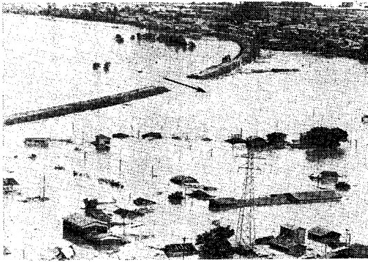
写真一 米代川の堤防決壊(矢印)で能代市に流れ込む濁流
