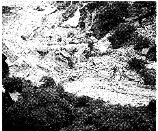
写真-9 神奈川県唐沢の被災状況
