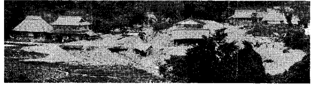
写真-8 島根県後畑谷川下流の被災状況
