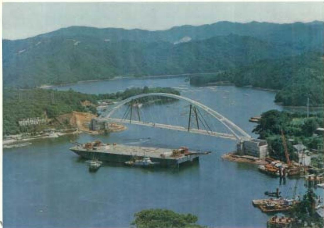
三重県企業庁の志摩開発有料道路（パールロード）が生浦港の河口を横断する地点に架橋された生浦大橋の主橋間に、支間 195 m のニールセンマーゼ橋が採用された。
