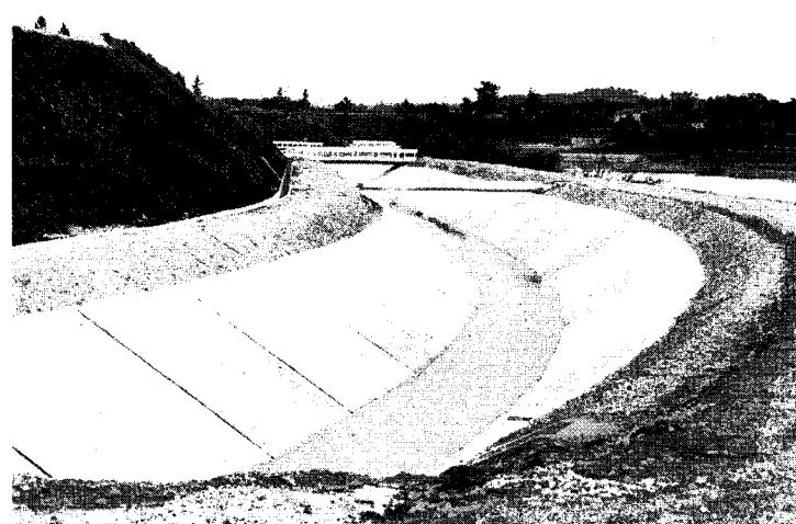
▲ 香川用水東部幹線水路・ $H=1.6\text{ m}$ ,  $B=7.25\text{ m}$ ,  $Q=6.6\text{ m}^3/\text{sec}$ ,  $I=1/3500$ .
