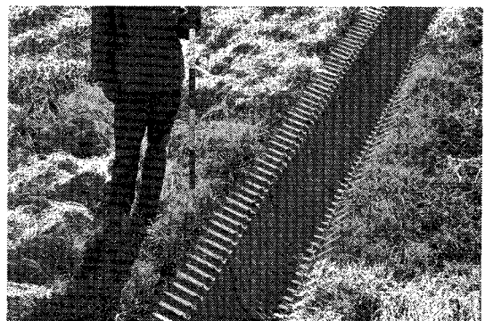
写真一3 盛土のり面に設けた排水溝
