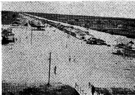
運河は潮沙の干満を利用したタイダルイリゲーションの導水路ともなっている。写真手前の木橋は支線水路にかけられたものである。
